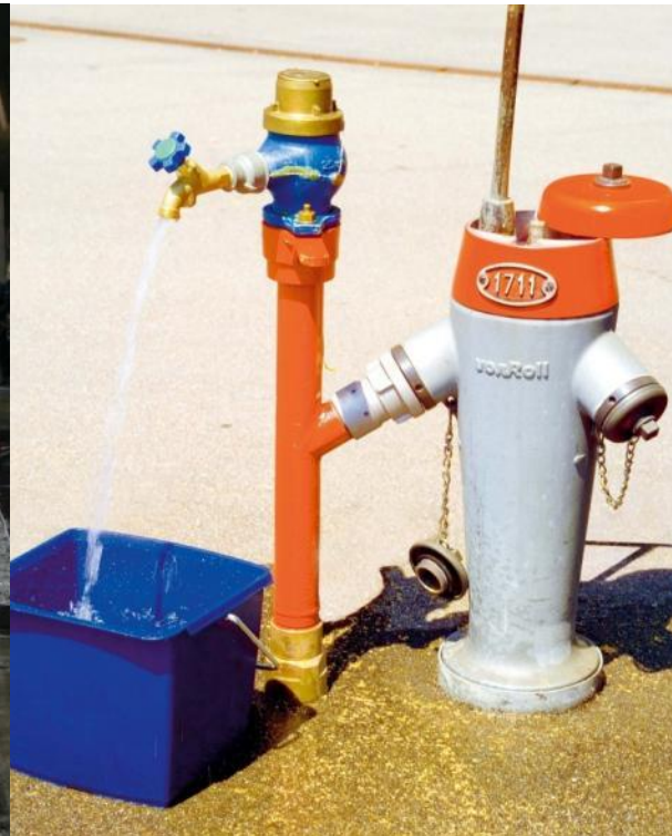
Installation von Zapfstellen
